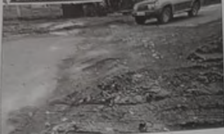
Работы по ремонту дорог. Проезд для автомобилиста.
